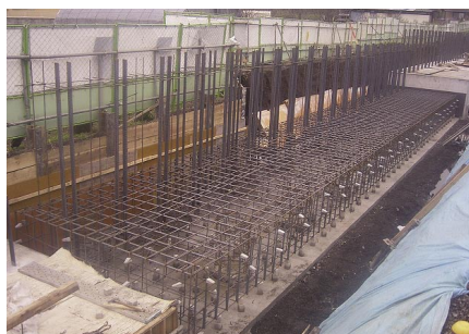
①基礎フーチング鉄筋組立
