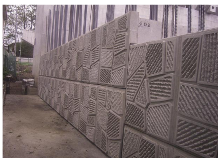
⑧2 段目据付
