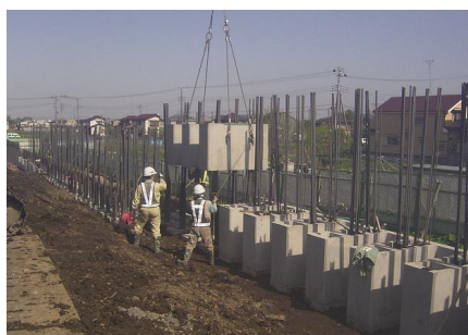
⑦2 段目据付状況
