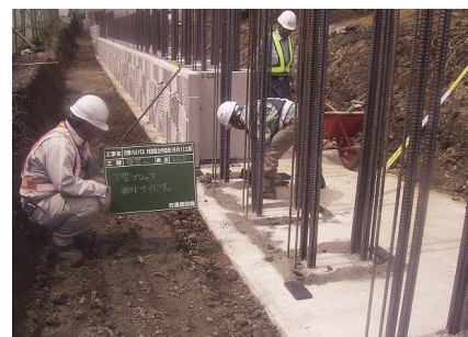
③調整モルタル敷設
