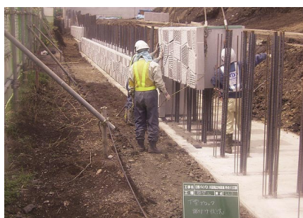
④1 段目据付状況
