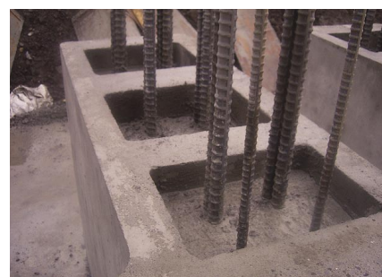
⑥生コンクリート下越し
