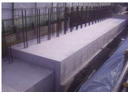
②基礎フーチング
